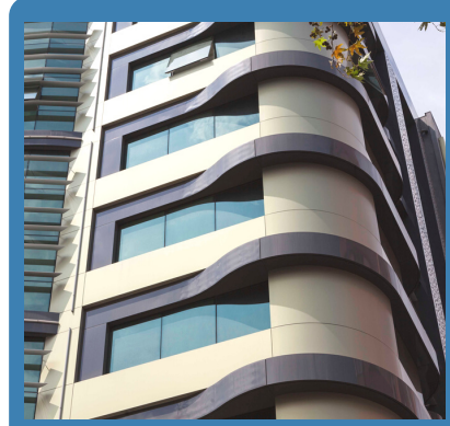
Kompozit Panel Uygulama
